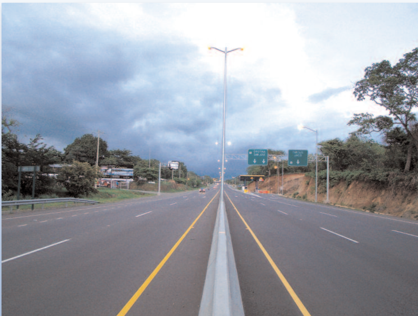
Nueva carretera a Caldera
