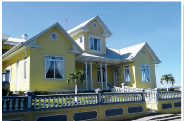
Figura 2: Fachada remozada Restaurante Casa Grande San Pablo de Barva.
