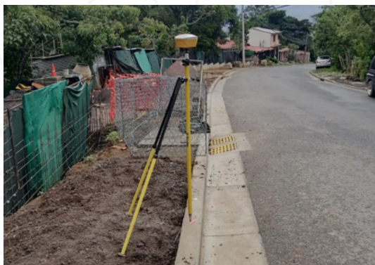
Figura 1: Colocación de punto de amarre para replanteos
