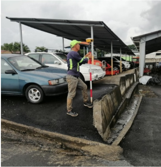
Figura 5: Levantamiento de detalles constructivos
